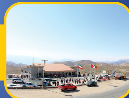
Mejoramiento del Servicio de Transitabilidad Vehicular y Peatonal en el Sector Cruce Chilligua
