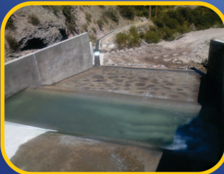
Mejoramiento del Sistema de Riego del Canal Principal en el C.P. Cambrune
