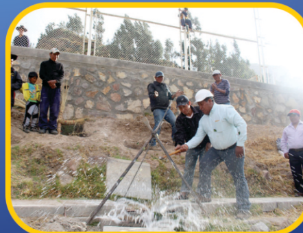
Mejoramiento del Canal de Riego Pampa Somoa en la Comunidad de Somoa
