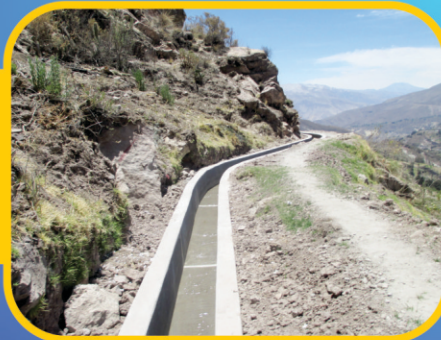
Mejoramiento del Sistema de Riego Huancarane - Somoa
