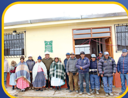
Mejoramiento del Salón de Usos Múltiples en la Parcialidad de Pampa Putina
