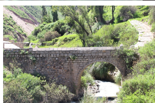
PUENTE COLONIAL ZIGZIGI
